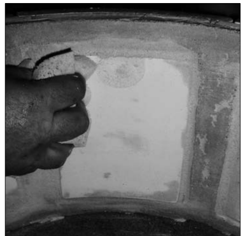
Nach kurzer Antrocknungszeit den Kachelring von innen mit einem feuchten Schwamm glätten.
