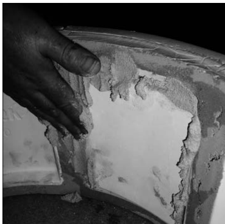
Die Spalten mit Mörtel auffüllen.
