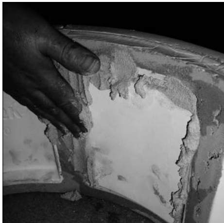
Die Spalten mit Mörtel auffüllen.
