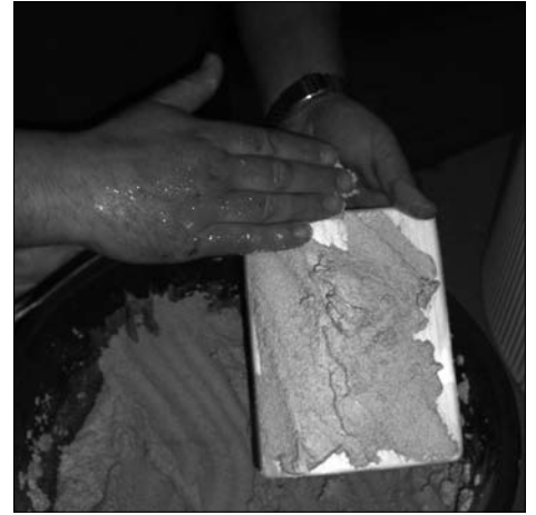
Mörtel auf den Schamottefutterstein auftragen.
