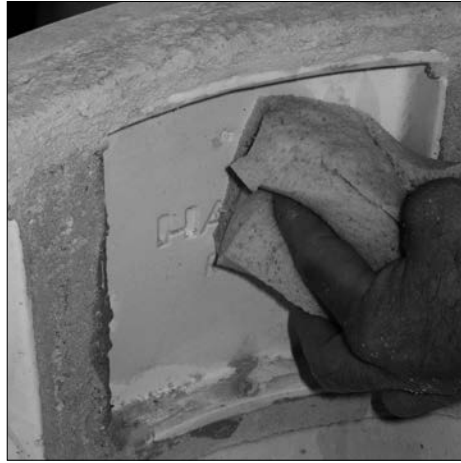
Kachelring innen mit einem Schwamm anfeuchten.
